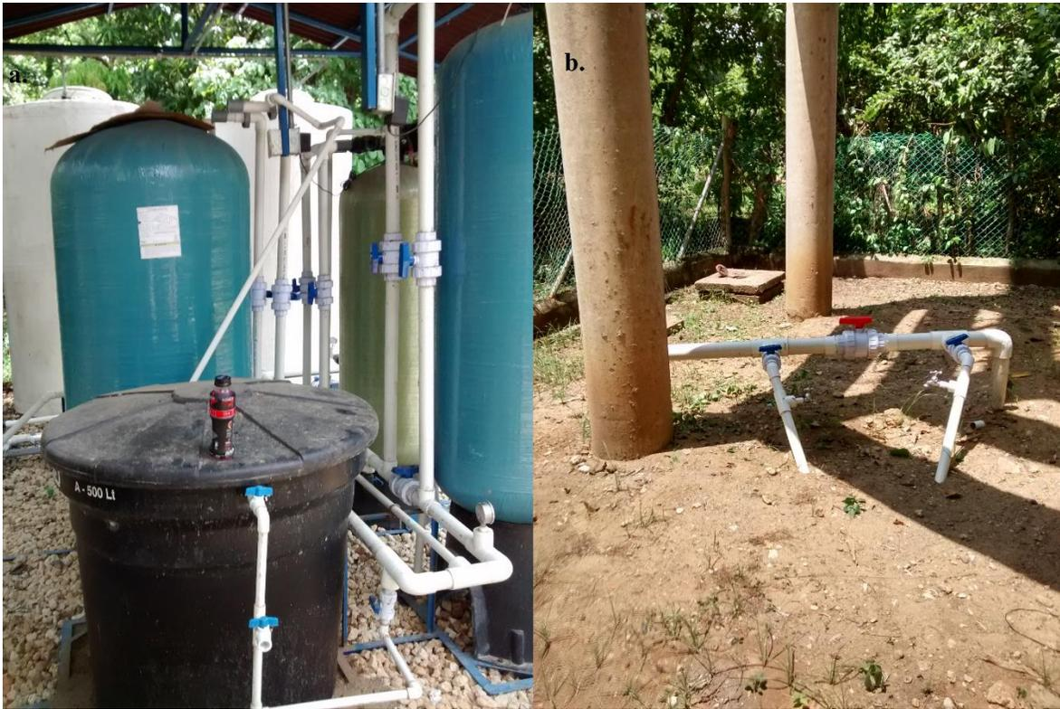
**Figura 7. a.** Planta potabilizadora de San Joaquín. **b.** Bomba de succión de San Joaquín.
