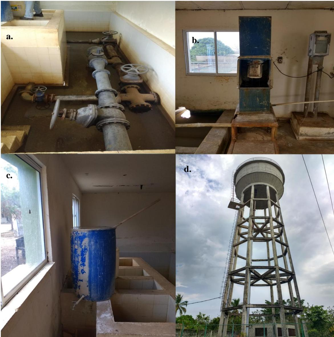
**Figura 3** Acueducto de Mahates. **a.** Tuberías deterioradas. **b.** Dosificador de  $\text{Al}_2(\text{SO}_4)_3$ .
