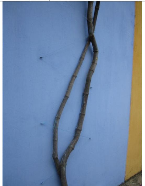
Sistema de anclajes a muros de las plantas trepadoras, con clavos y alambres. (Castellar Herrera, 2012)
