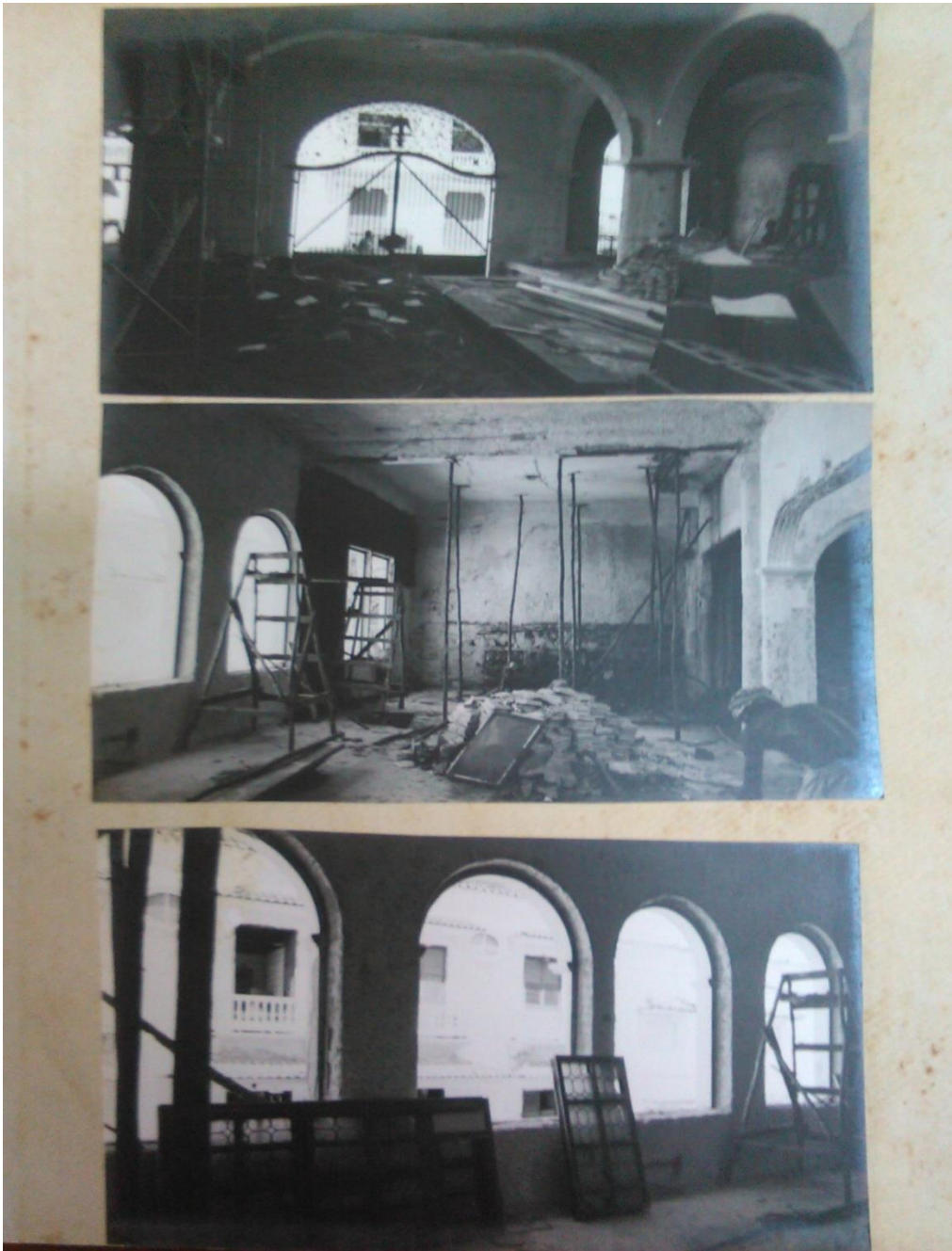
Foto No. 13 105 : trabajos de remodelación Biblioteca Bartolomé Calvo.
