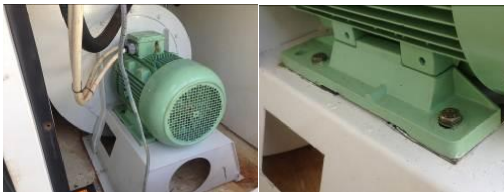
Figuras 16 y 17 Corrección de fallas en el anclaje de motor eléctrico trifásico en sistema de extracción, verificación y ajustes a tornillos, limpieza de canastas recolectoras de polvo Fuente: Base de datos rep COTECMAR
