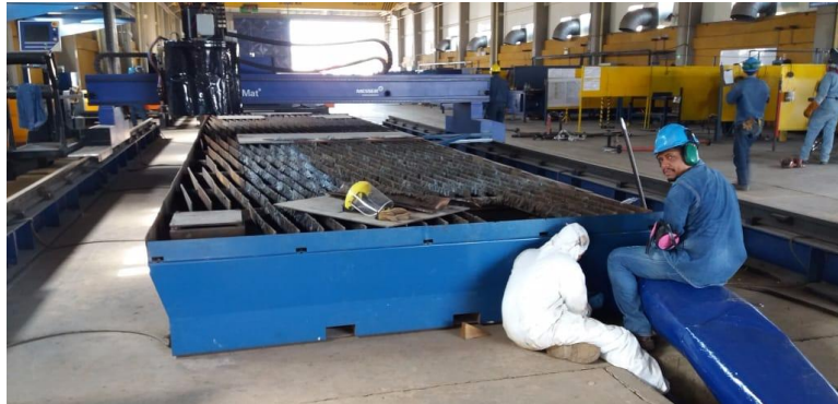
Figura 9 Mesa de Corte CNC para corte de lámina CNC OmniMat I 6000 en mantenimiento en las instalaciones de COTECMAR
