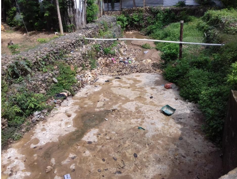
Fotografía 1. Muros de gaviones sobre el sector calle Franco, Arroyo Hormiguero.
