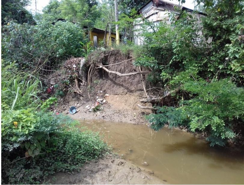
Fotografía 11. Socavación en predios de privados que colindan al canal, sector La Paz.
