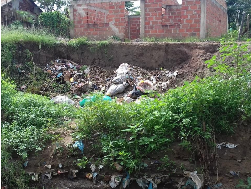
Fotografía 7. Acumulación de basuras en el arroyo Hormiguero.
