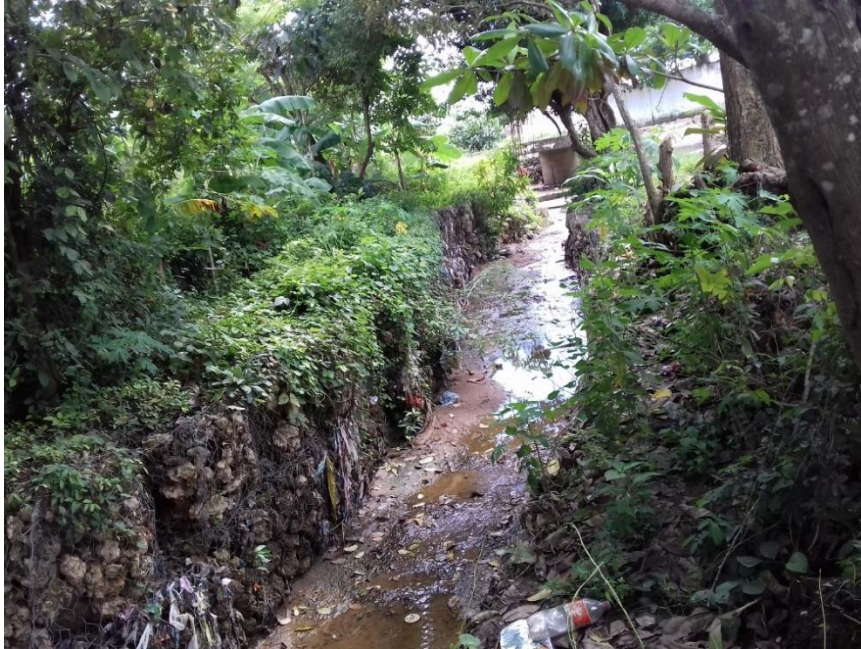
Fotografía 3. Muros de gaviones, arroyo Hormiguero, sector La Paz
