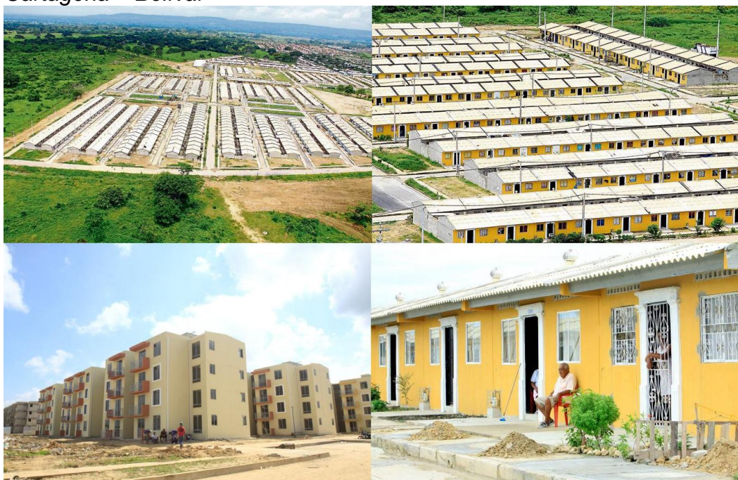
Figura 10 Soluciones de vivienda vertical y horizontal en Ciudad del Bicentenario, Cartagena – Bolívar
