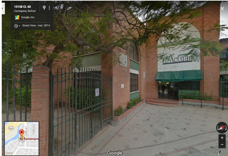
Fachada del Centro de Desarrollo
