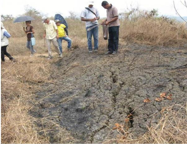
**Ilustración 38.** Hundimiento diferencial zona volcán de lodo, deforestación por quema de vegetación en la zona.
