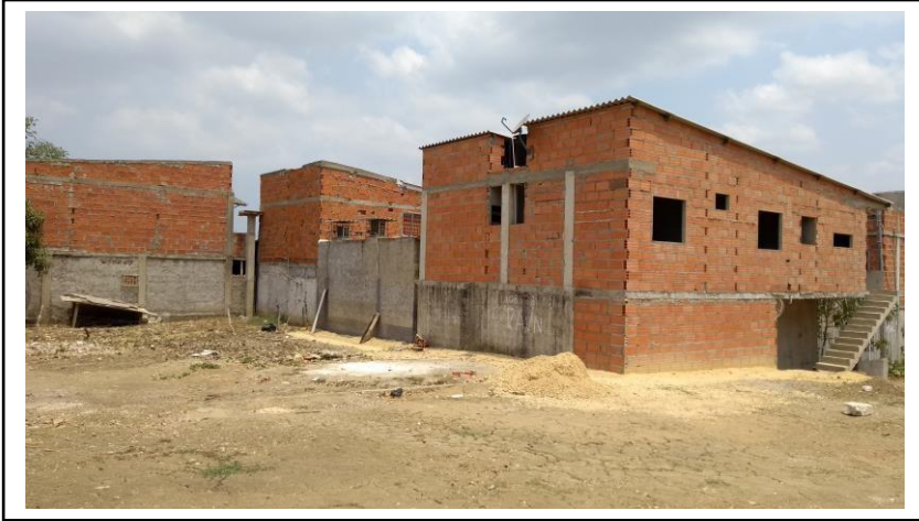
Anexo 6. Crecimiento urbanístico El Rodeo - sector 3. Sin evidencia de daños construcción en desarrollo.
