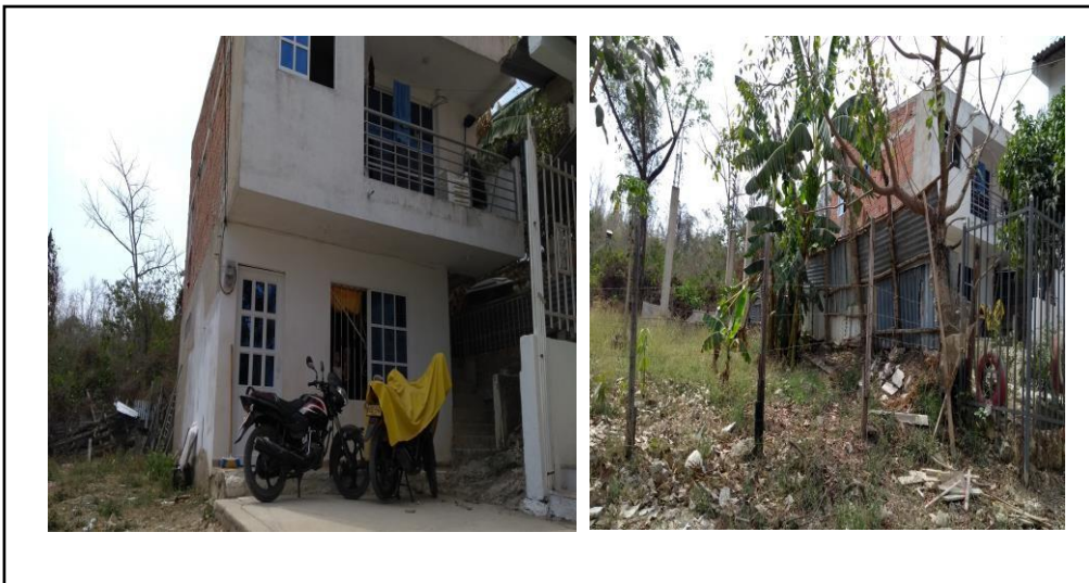
Anexo 5. Casa de esquina El Rodeo – sector 3 Mz 9, estado de daño bajo.
