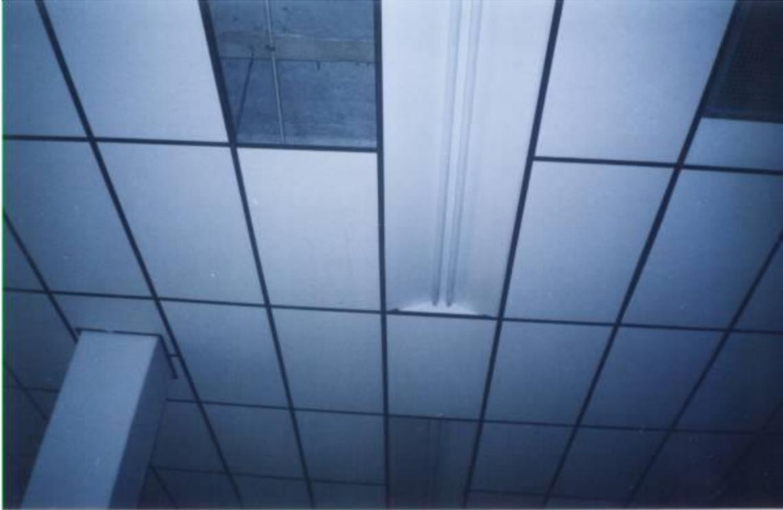
**Figura 8. Orificios en techos de la Planta.**
