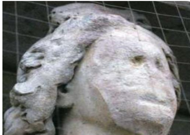
Imagen 12. Desintegración Granular
