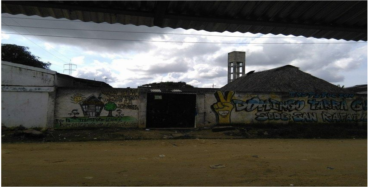
Foto: Fachada de entrada de la Institución Educativa San Rafael de la Cruz
