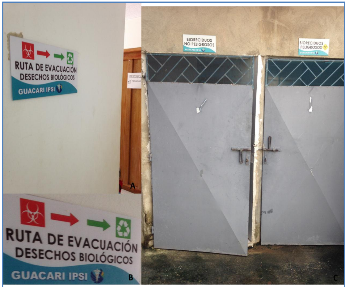
Figura 13. Señalización de la ruta de evacuación de desechos biológicos
