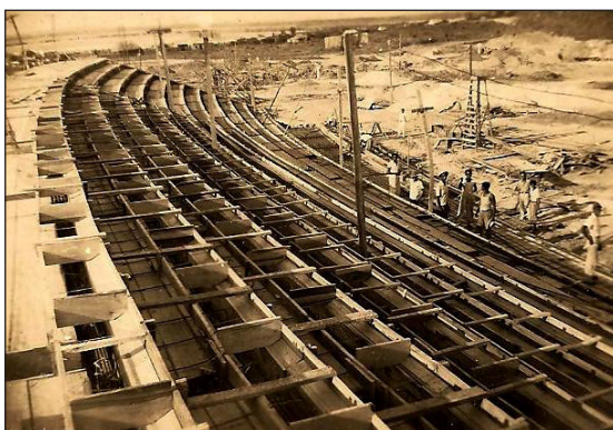
Avance de la obra
