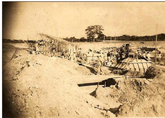
Fundición de la primera grada de sol
