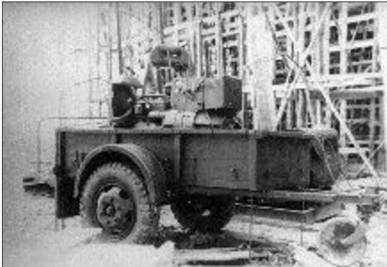
Planta eléctrica - Al fondo la formaleta
