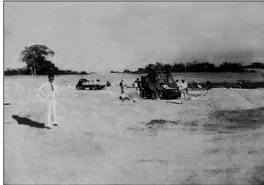
Se inician las obras por la tribuna de sol, lado izquierdo
