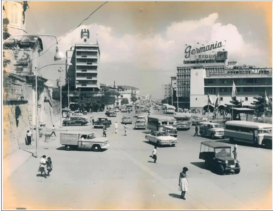
Primeras manifestaciones de la arquitectura moderna, a fines de los cincuenta, sector La Matuna (FHC)
