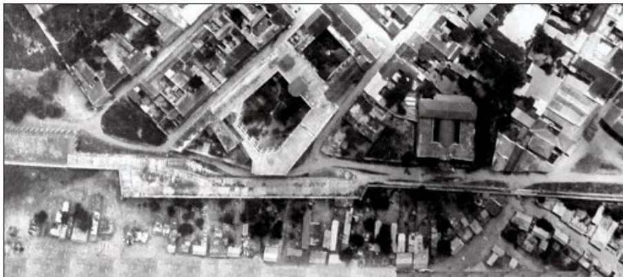
Barrio El Boquetillo, al pie de la muralla, hacia 1938 (FHC).
