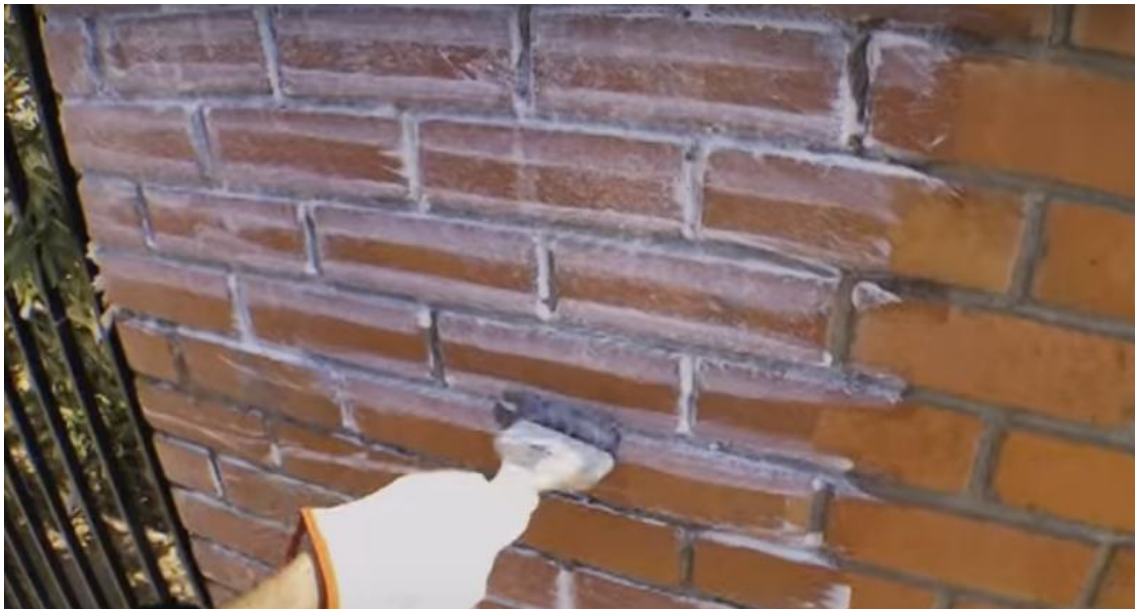
Ilustración 11 Impermeabilización de muro
