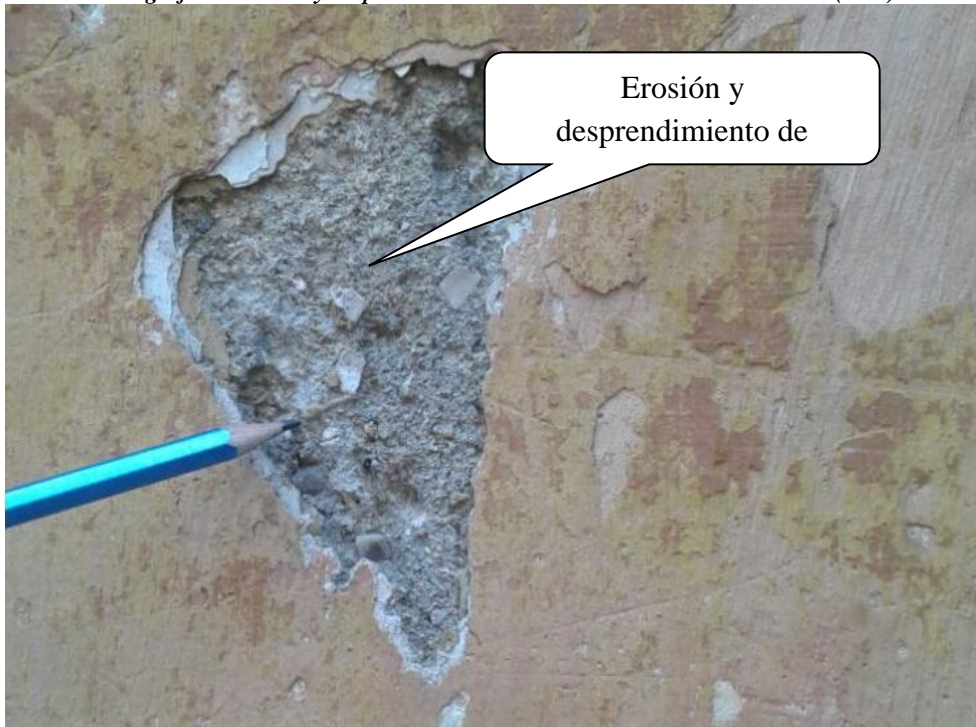
Fotografía 1 Erosión y desprendimiento de material en el muro de la casa (6-44)
