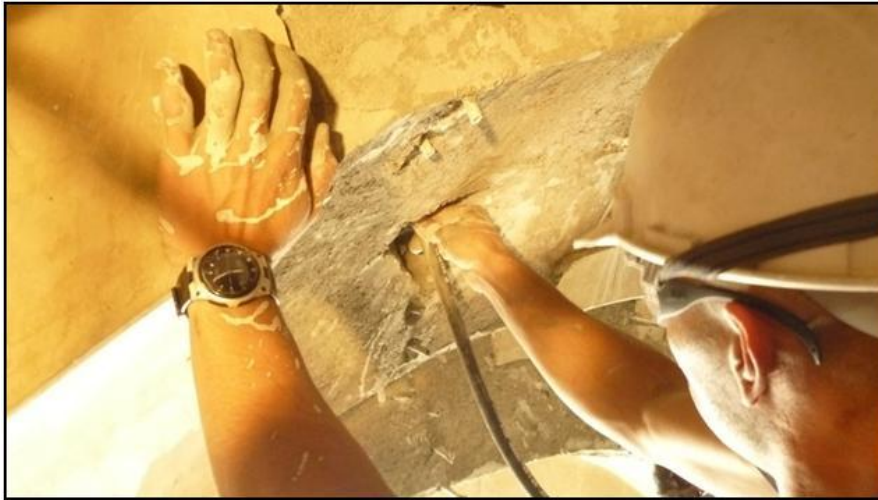
Ilustración 12 Reparación de grieta
