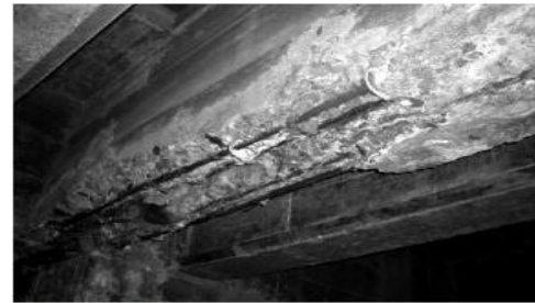
Desconchamientos y exposición de acero en traves
