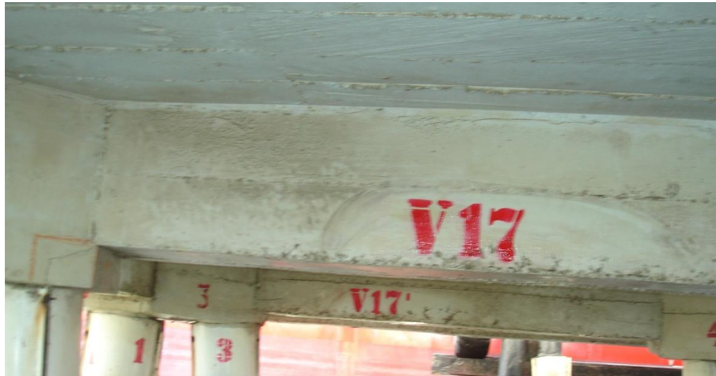
Figura 33. Plataforma en buen estado
