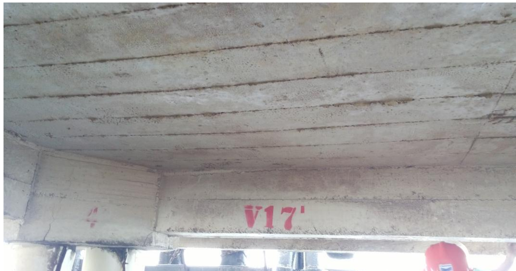
Figura 34. Plataforma en buen estado
