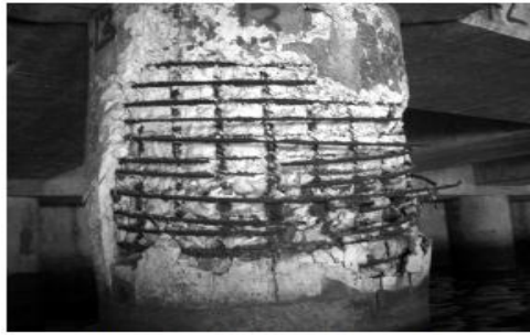
Pila con exposición de acero (caso único)
