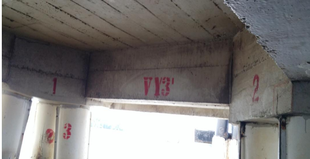
Figura 36. Viga Y 3 del tablero
