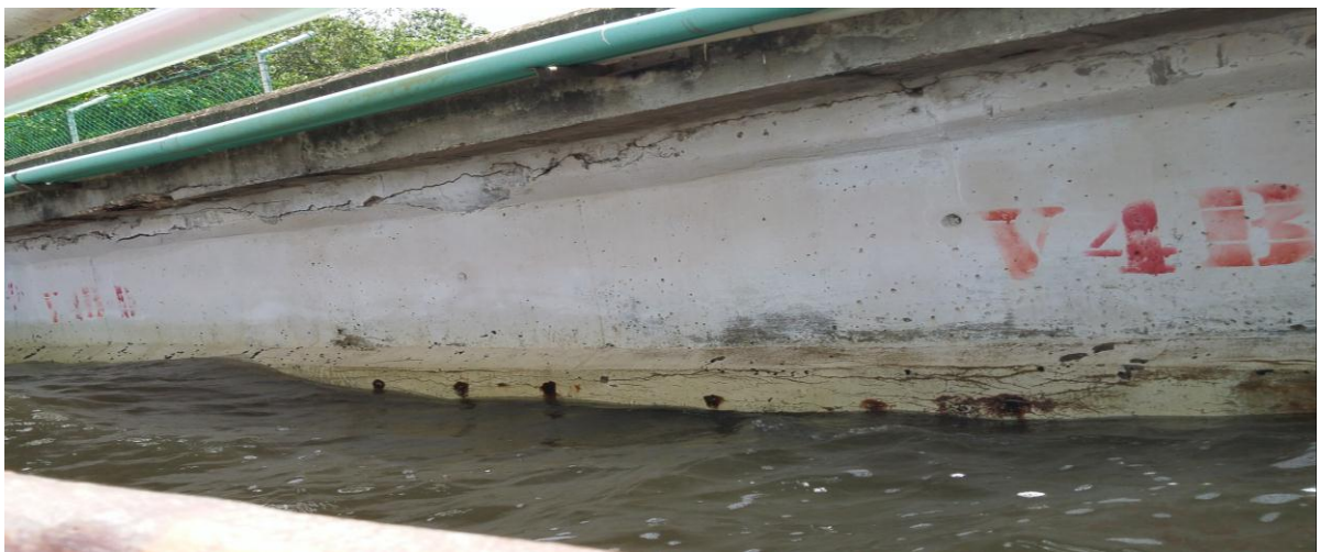
Figura 19. Viga 4 eje B
