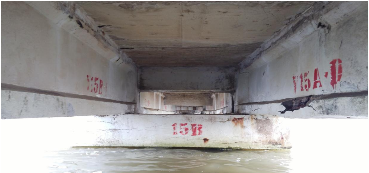
Figura 21. Pasarela y vigas 15 ejes A -B
