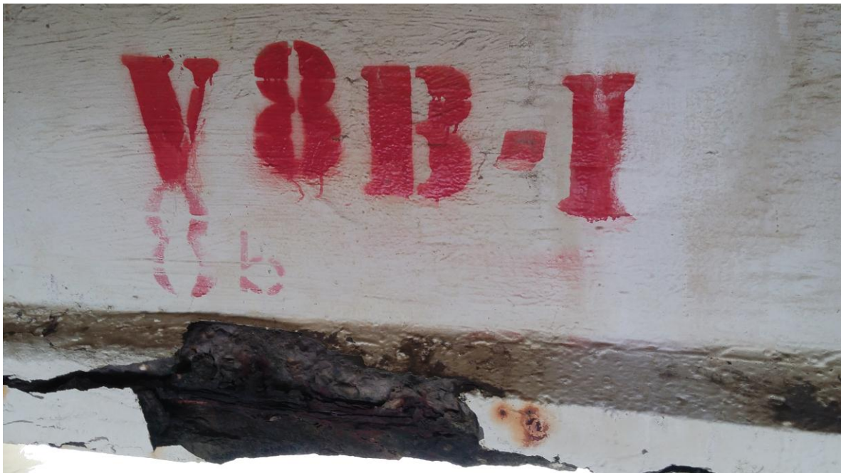
Figura 25. Viga 8 eje B
