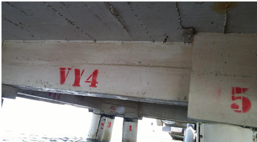
Figura 37. Viga Y 5 del tablero
