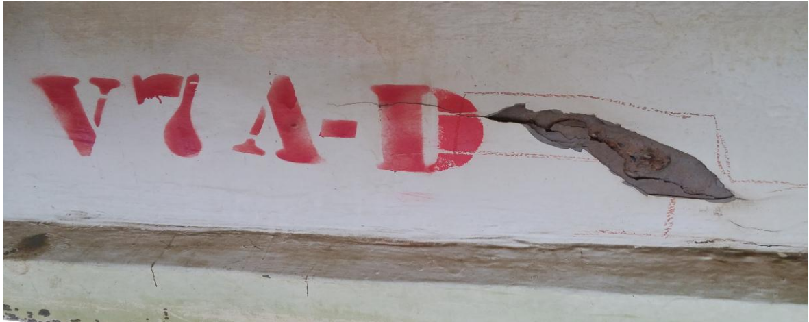
Figura 24. Viga 7 eje A
