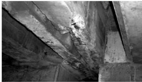
Desconchamientos y exposición de acero en traves
