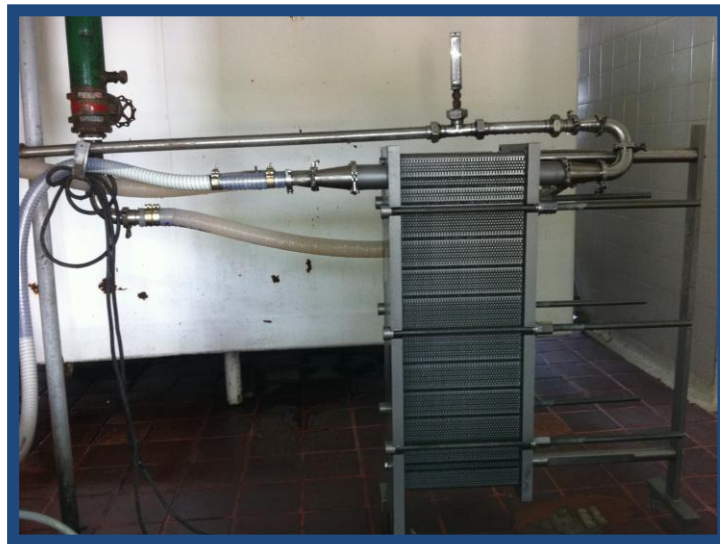
Sistema de Refrigeración por Placas
