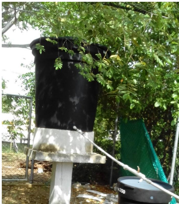
Figura 9. Tanque de almacenamiento de aguas a tratar. (Fuente: Elaboración propia)
