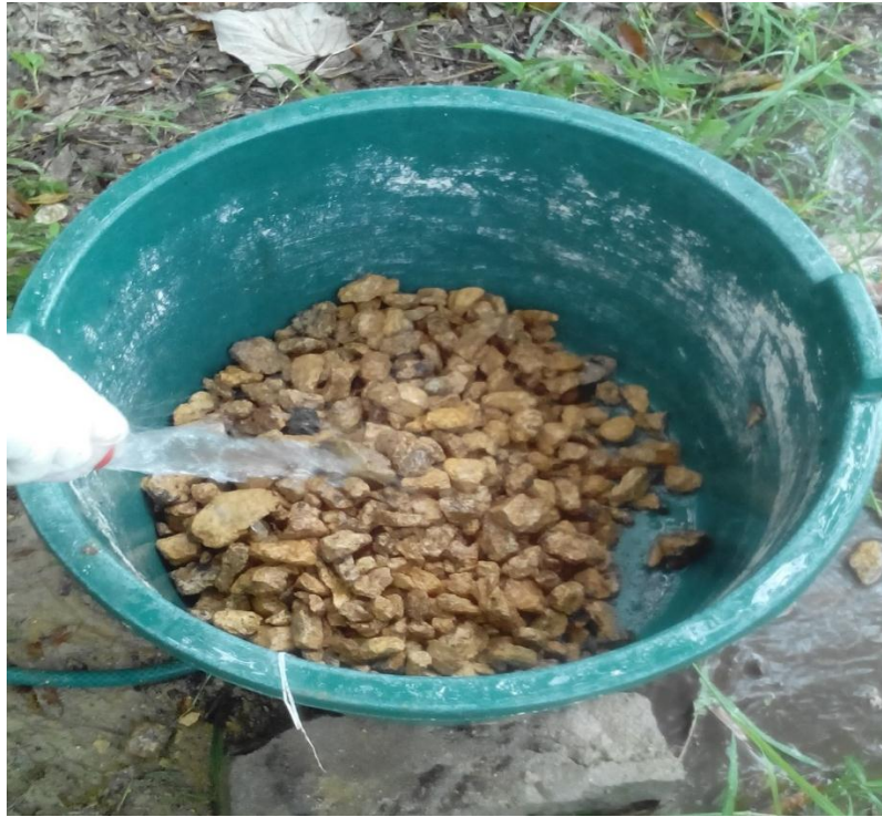
Figura 14. Limpieza material granular humedales.
