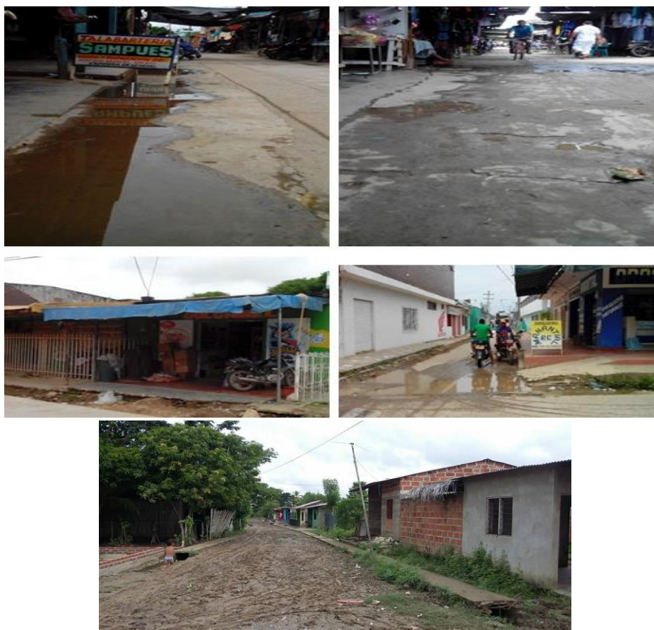
Foto No. 9 Estado de las vías Municipio de Majagual. 56
