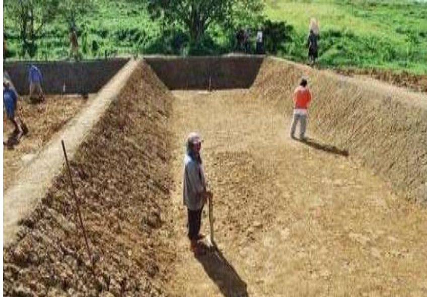
Imagen 9. HA FS en construcción en Bayawan, Filipinas (Fuente: J. Boorsma, 2009)
