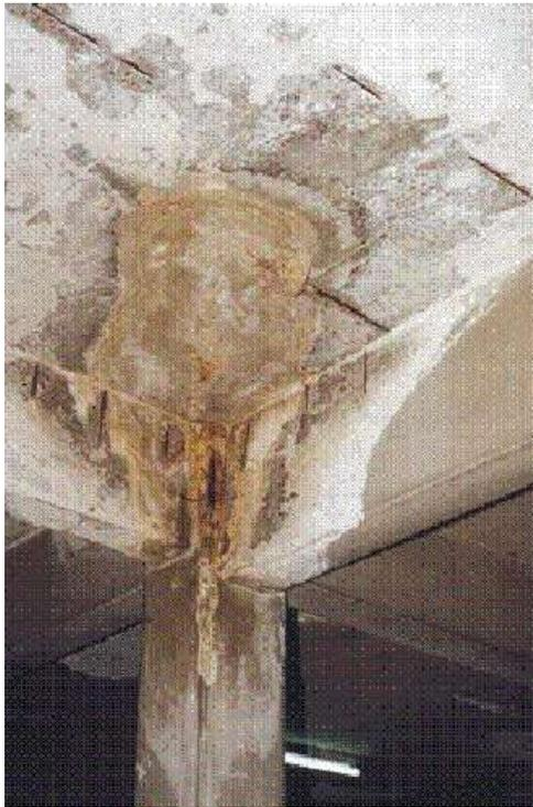
**Ilustración 4** Muestra de Eflorescencias con pérdida de alcalinidad y corrosión de armaduras. Fuente: Rehabilitación y mantenimiento de estructuras de concreto.
