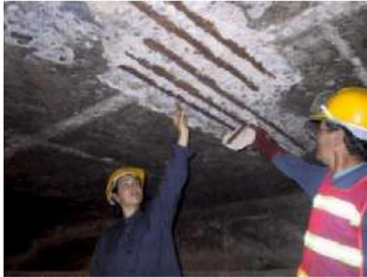
**Ilustración 5** Corrosión de barras de acero en la cara inferior de una losa. Montevideo, Uruguay. Fuente: *Rehabilitación y Mantenimiento de Estructuras de Concreto*
