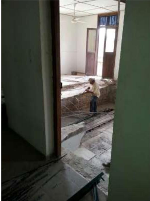
**Ilustración 20 Tarima de demolición y personal cortando aceros de refuerzo de la placa antigua**
