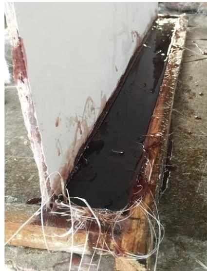
**Figura N°61.** Relleno con resina en pestañas
