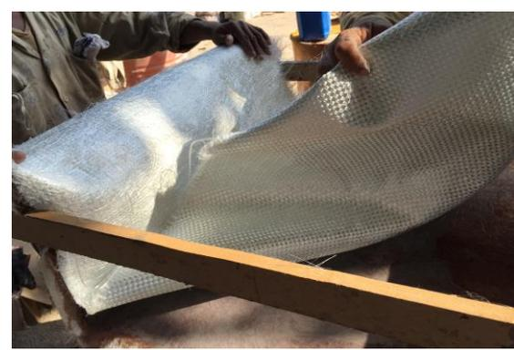
**Figura N°41.** Aplicación de segunda capa, Combo
