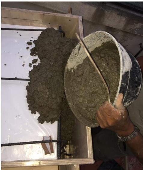
**Figura N°73.** Vaciado del concreto en viguetas
