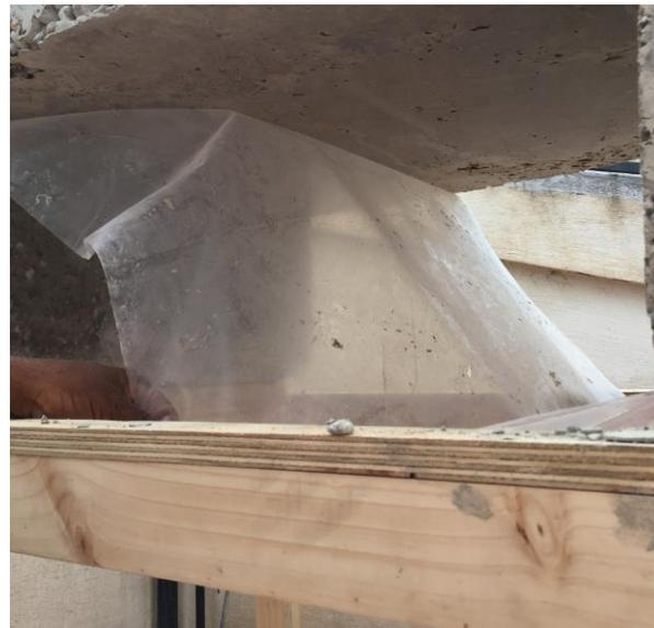
**Figura N°78.** Acabado obtenido por la formaleta en la parte interna del concreto.
