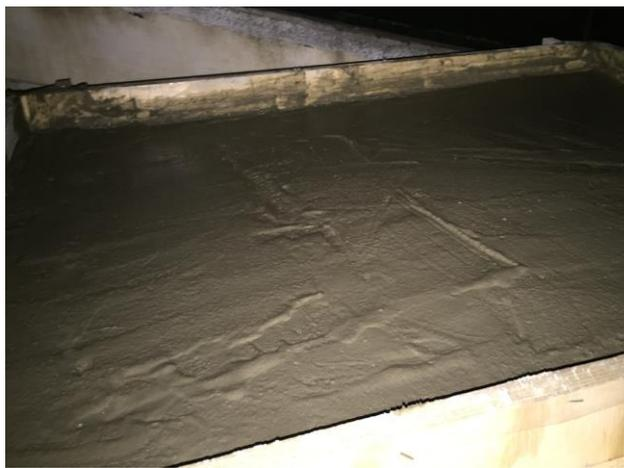
**Figura N°76.** Vaciado y nivelación del concreto finalizado
