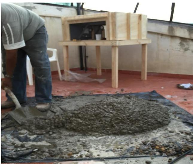
**Figura N°72.** Preparación del concreto
