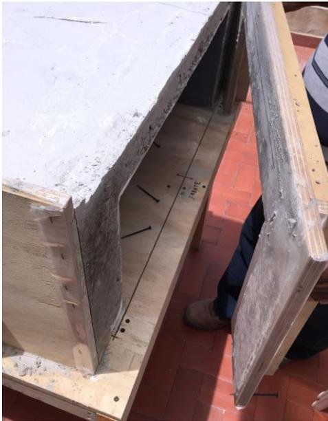
**Figura N°77.** Retiro de estructura de madera.
