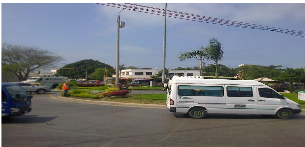
Figura 23. Vista general de la intersección 4
