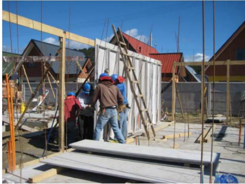
Figura 5. Montaje de prefabricados hechos con ferrocemento. Fuente: (Andrea Jaramillo, 2010)
