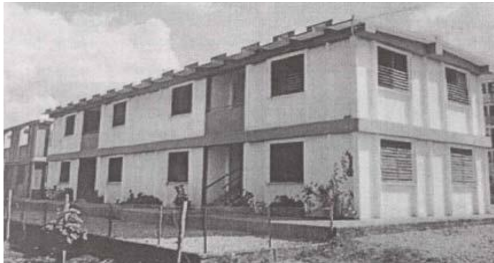
Figura 4. Viviendas Estructuradas con ferrocemento. Fuente: (Ruiz, 2005)
