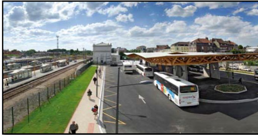
Figura 4. Terminal del tren de alta velocidad, Eurolille.
