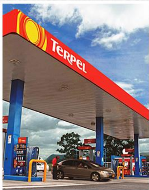
Estación de servicio Terminal de Carga, Bogotá.
