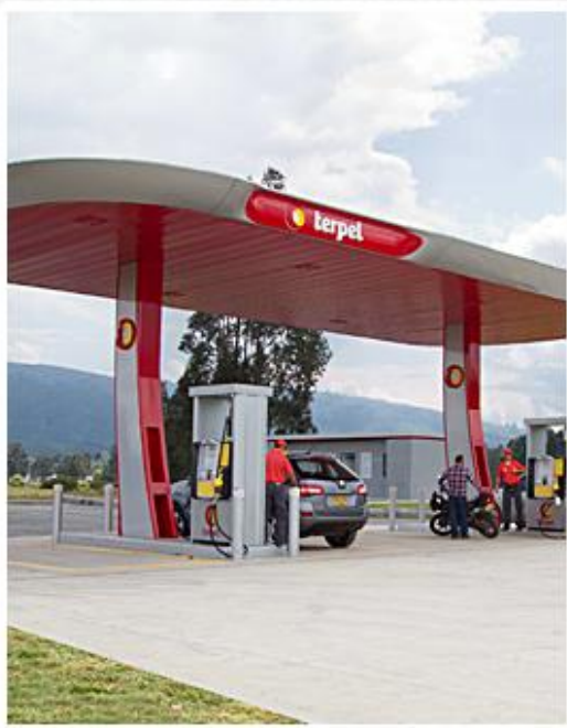
Estación de Cogua, Cundinamarca
