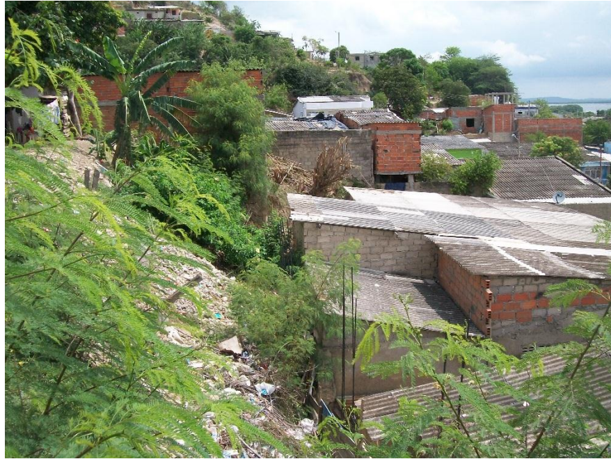
Figura 44. Erosión pluvial de talud en zona de estudio, coordenadas 10^{\circ}25'25.50''N , 75^{\circ}31'5.95''O
