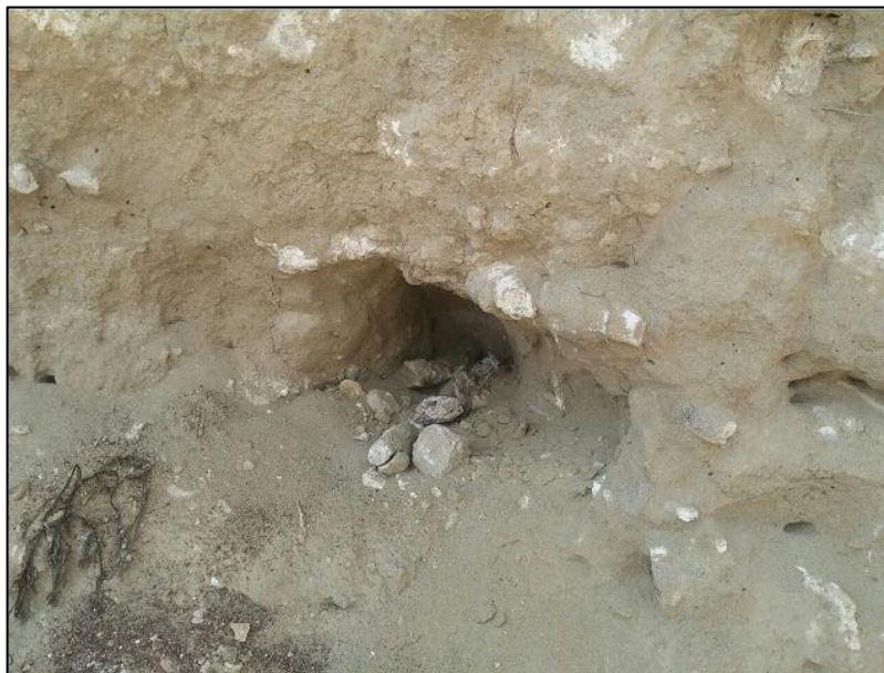
Figura 22. Afloramiento de arenas sueltas de grano fino a medio con concreciones arenosas calcáreas.
