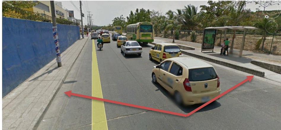
Figura 56. Infraestructura para discapacitado en zona inadecuada
