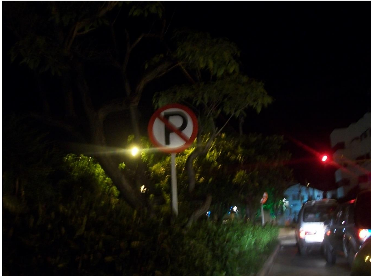
Figura 52. Señal obstruida y poco iluminada por arboles del centro deportivo
