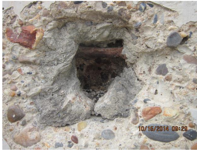
Imagen 29. Prueba de Carbonatación en Escaleras.
