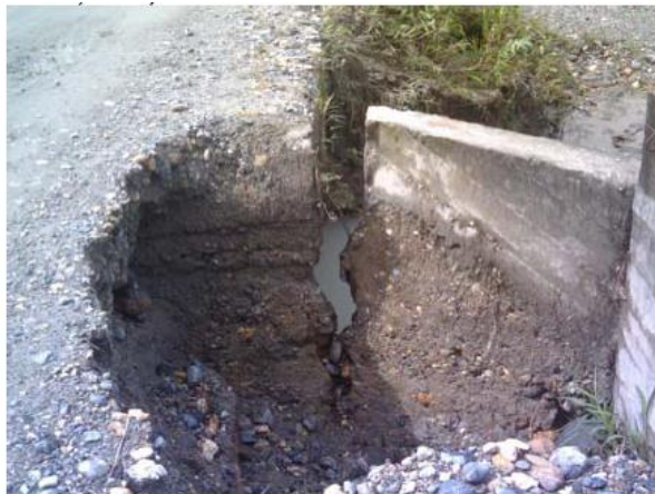
Imagen 9. Volcamiento de una aleta. Puente Pacamí, Chocó.
