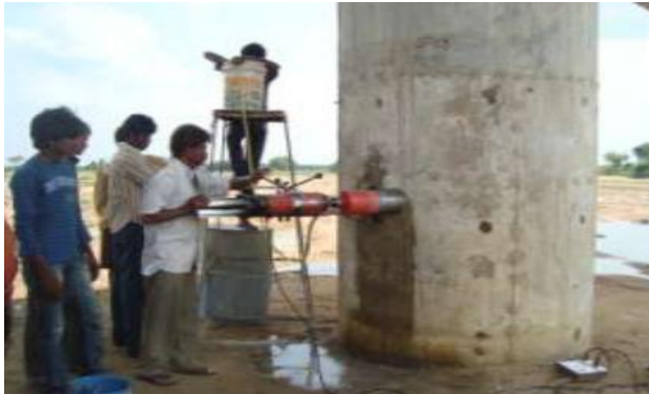
Imagen 7. Extracción del núcleo de hormigón del puente Pier
