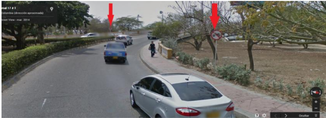
Fotografía 9. Detalle de la presencia de señalización vertical en el puente.
