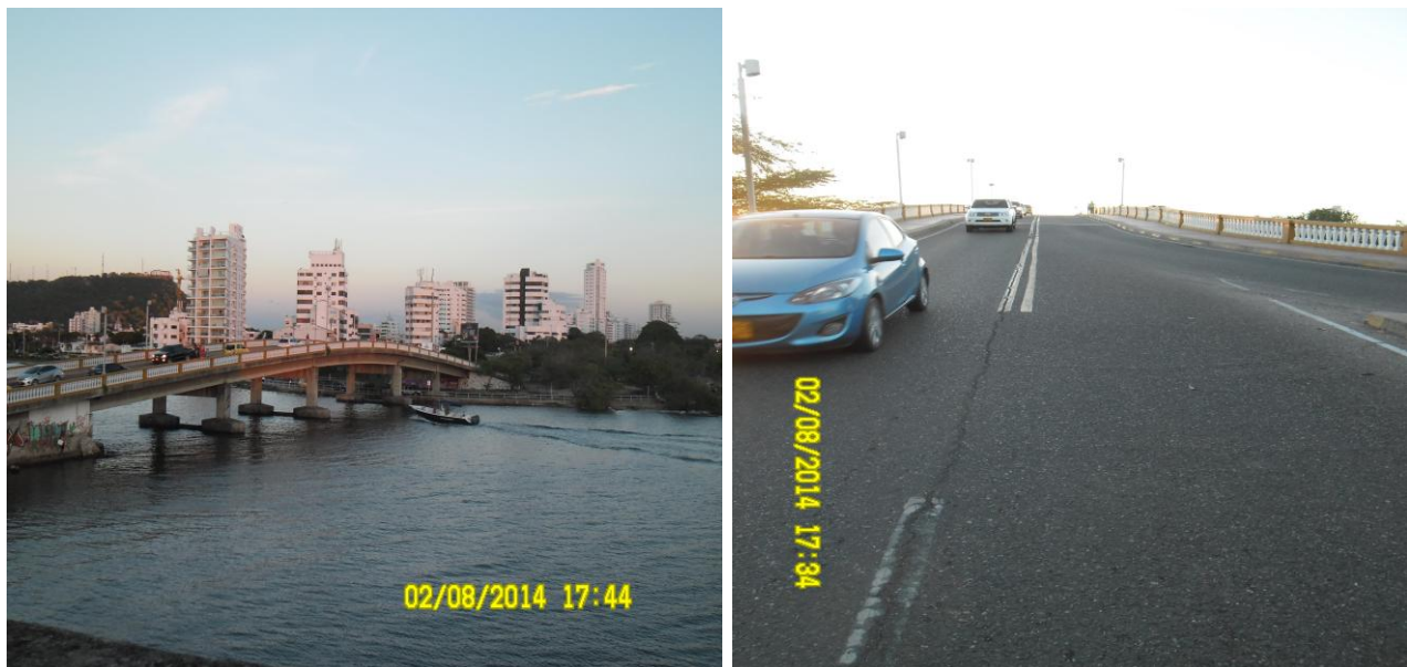
Fotografía 2. Fotos panorámicas de perfil y de la superficie del Puente Román.
