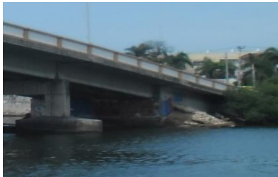
Fotografía 4. Socavación de elementos de protección de taludes y estribo N° 2
