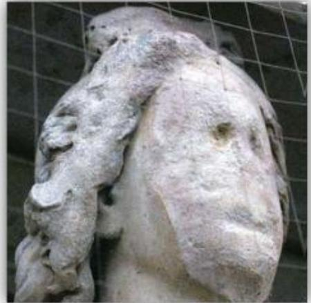
*Pulverización (Desintegración Granular)*
