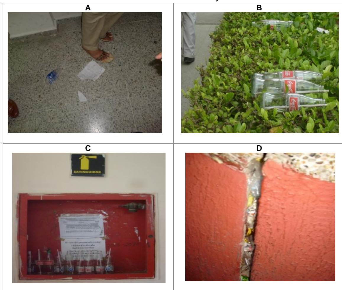
Foto No. 4 Residuos sólidos en los corredores y áreas verdes
