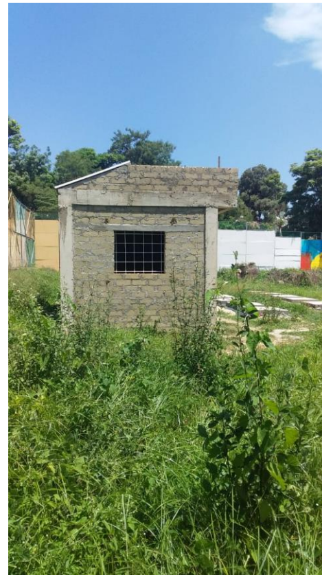
Ilustración 13. Fachada este de la unidad habitacional Fuente: (Barón & Navarro, 2019)
