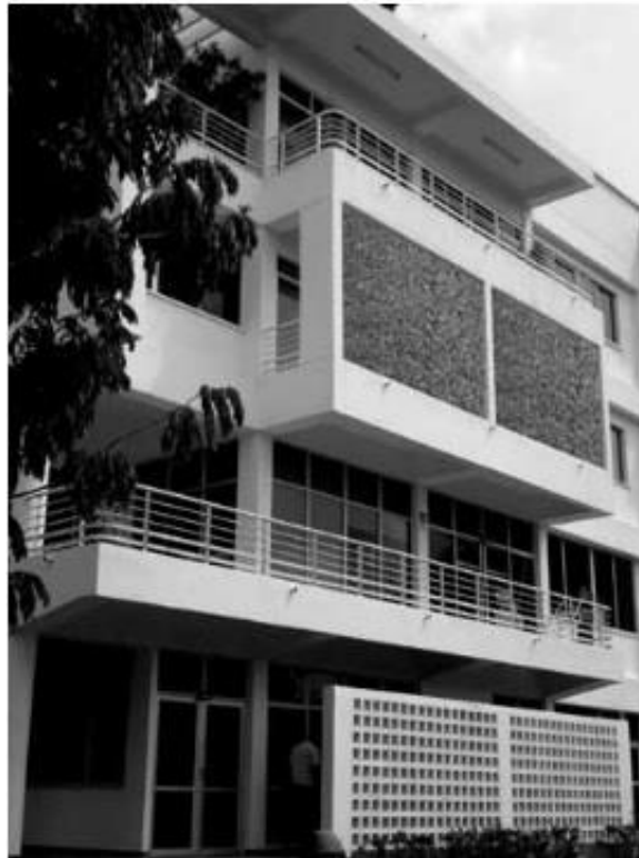
Ilustración 1. Fachadas verdes instaladas en el edificio administrativo Universidad Pontificia Bolivariana, seccional Montería.
