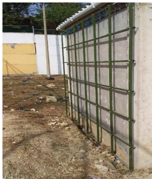
Ilustración 22. Estructura metálica anclada al muro de la unidad. Fuente: (Barón & Navarro, 2020)
