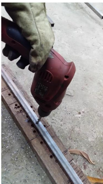
Ilustración 21. Perforación de perfiles metálicos. Fuente: (Barón & Navarro, 2020)
