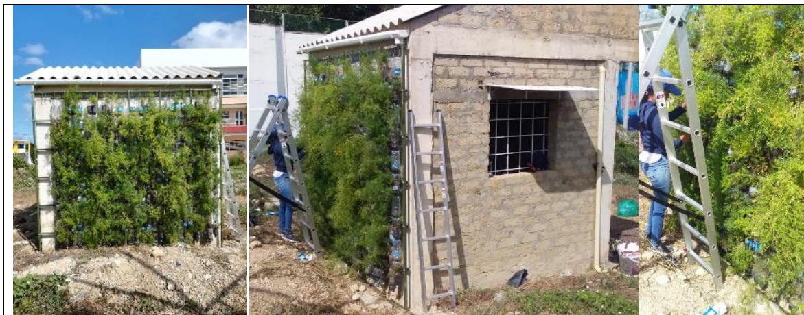
Ilustración 29. Muro verde con Espárrago, ubicado en la fachada Sur. Fuente: (Barón & Navarro, 2020).
