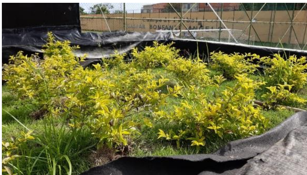
Ilustración 15. Techo verde ubicado en una unidad. Construido por SIMA Fuente: (Barón & Navarro, 2019)
