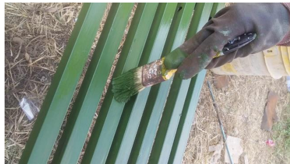
Ilustración 24. Impermeabilización de perfiles metálicos Fuente: (Barón & Navarro, 2020)
