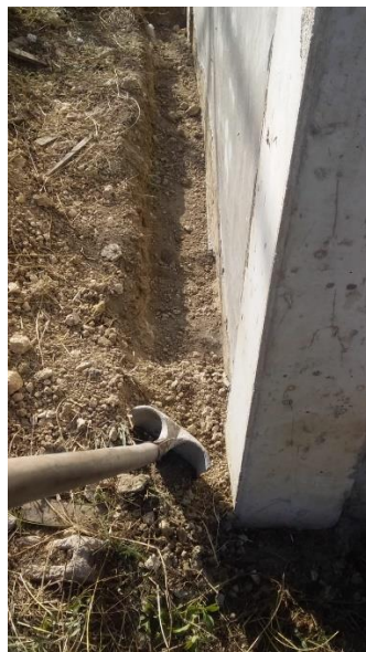
Ilustración 25. Adecuación de terreno. Fuente: (Barón & Navarro, 2020)
