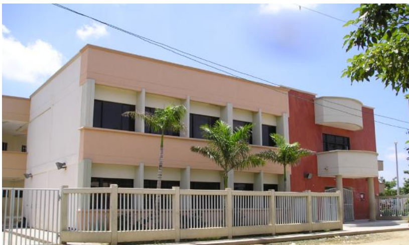
Foto 2. Vista externa I. E. Luis Carlos Galán Sarmiento. Fuente: Arroyo, B.
