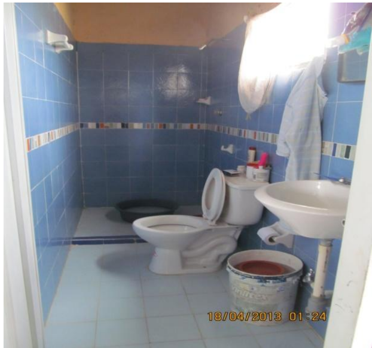
Foto tomada por: Sully Oviedo. Unidades Sanitarias Construidas a los Beneficiarios del Proyecto.
