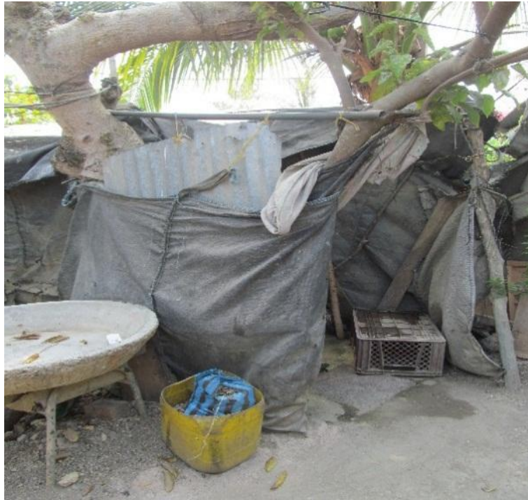
Foto tomada por: Lizeth Castellar. Unidades sanitarias de los beneficiarios del proyecto antes de la intervención.
