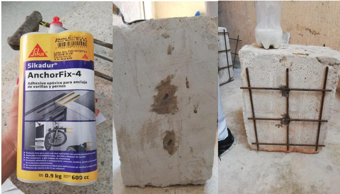
*Ilustración 26. Epóxico empleado en las perforaciones e instalación de la malla con sus anclajes.
