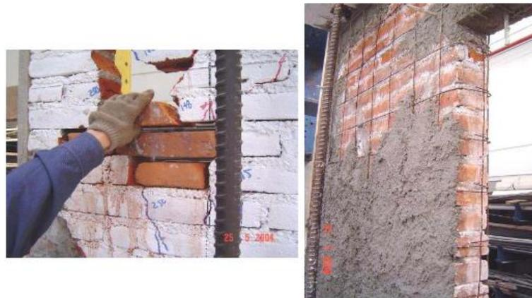
*Ilustración 1. Reparación de las piezas más dañadas y malla con recubrimiento en mortero.
