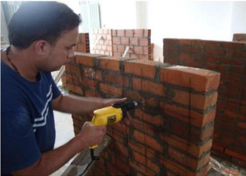
*Ilustración 2. Perforación de muretes para colocación de anclajes.*
