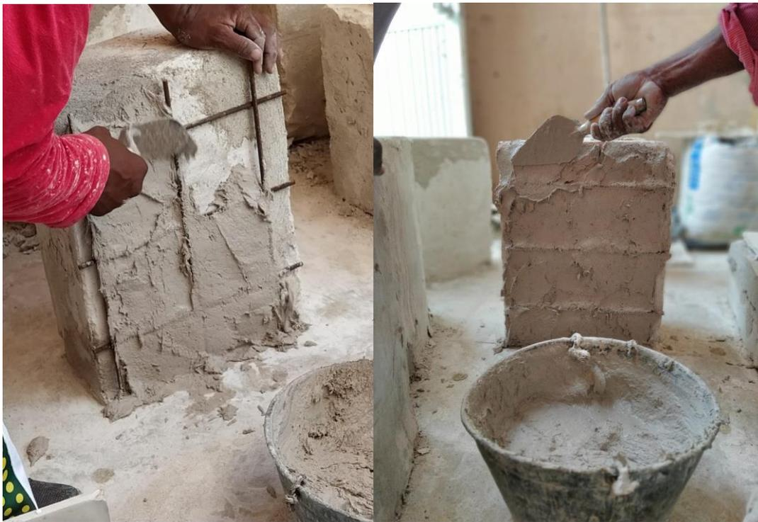
*Ilustración 28: Aplicación de mortero de recubrimiento en murete.
