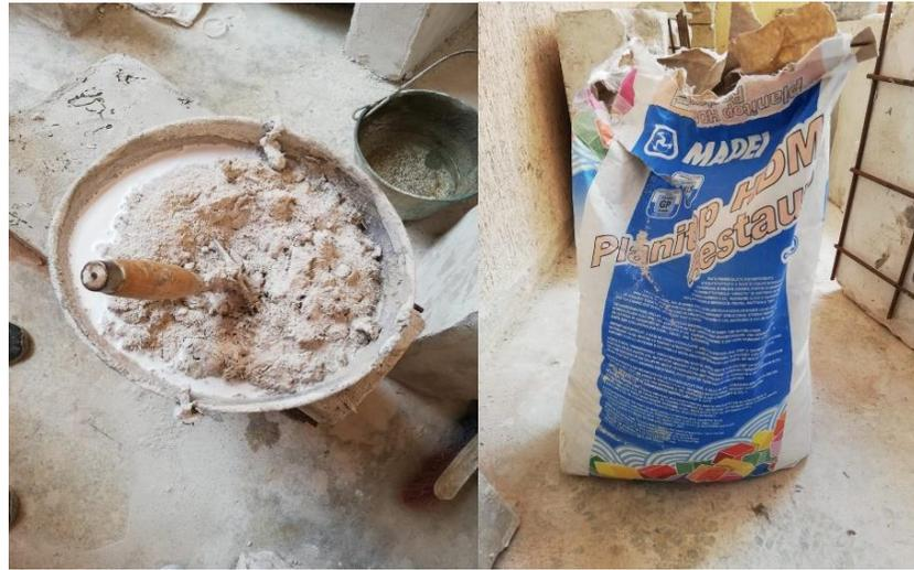
*Ilustración 27. Preparación de mortero de recubrimiento a emplear en la mampostería.
