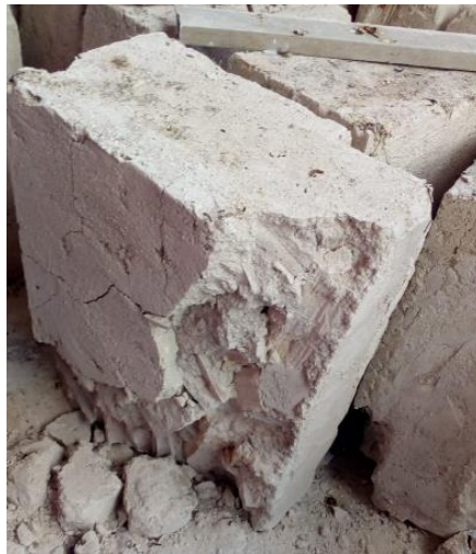
Figura 55. Agrietamiento y desprendimiento del mortero de revestimiento a base de cal apagada
