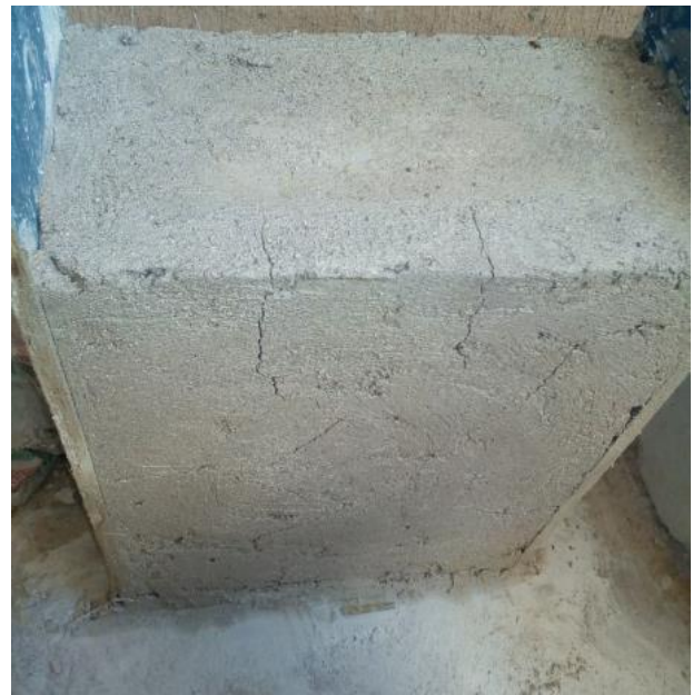
Figura 54. Revestimiento de muretes con mortero a base de Cal apagada reforzado con fibras al 0.06%
