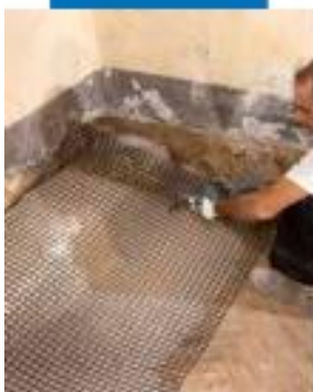
Colocación de la malla de fibra de vidrio resistente a los álcalis Mapegrid G 220
