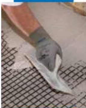
Aplicación con llana de la segunda capa de Planitop HDM Restauro en el extradós de una bóveda, cubriendo de forma homogénea la malla Mapegrid G 220
