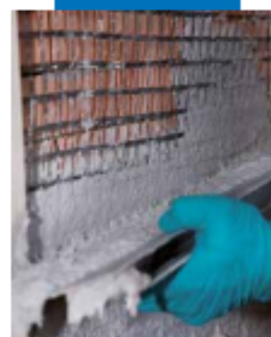
Aplicación del sistema Planitop HDM Resauro y Mapegrid G 220 sobre una pared de albanilería
