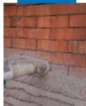
Aplicación por proyección de Planitop HDM Resauro sobre una pared de albanilería
