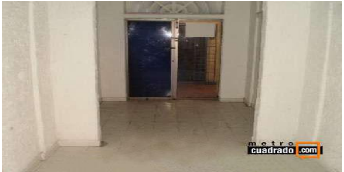
Ilustración 1. Local Comercial en arriendo (estado actual) 50
