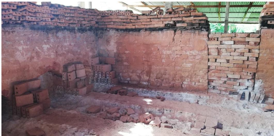
**Foto 14:** Parte interior del Horno para la cocción de ladrillos.
