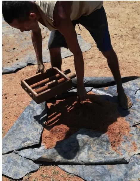
**Foto 5:** Adición de aserrín al molde, evitando la posible adherencia de la masa arcillosa a este.
