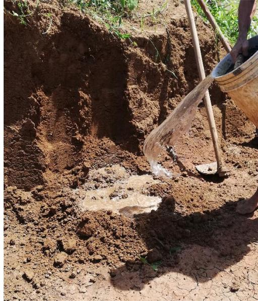
**Foto 3:** Inicio del proceso de elaboración de la masa de arcilla.
