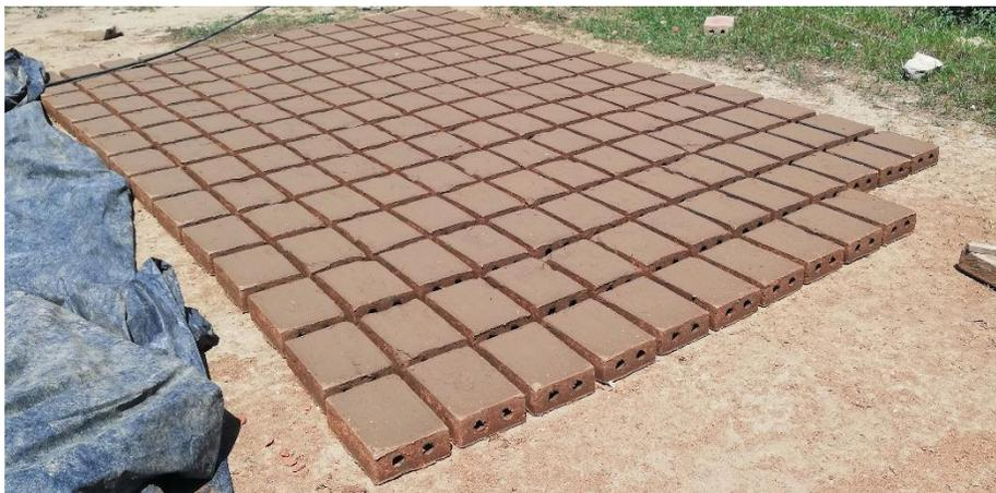
**Foto 10:** Proceso de secado al sol de los ladrillos de arcilla.
