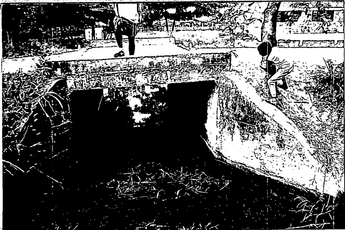
FOTO No 26. Culvert No 7. Arroyo Arroz Barato.
