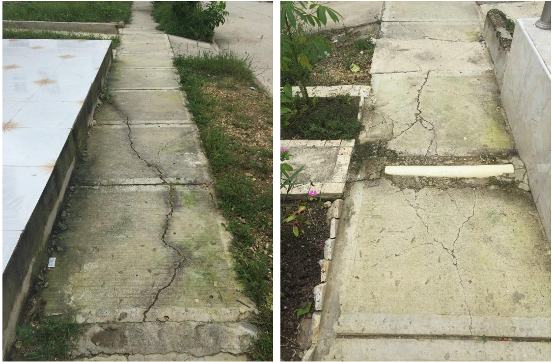
Figura 25. “Desprendimiento de adoquín y hundimiento en vía”
