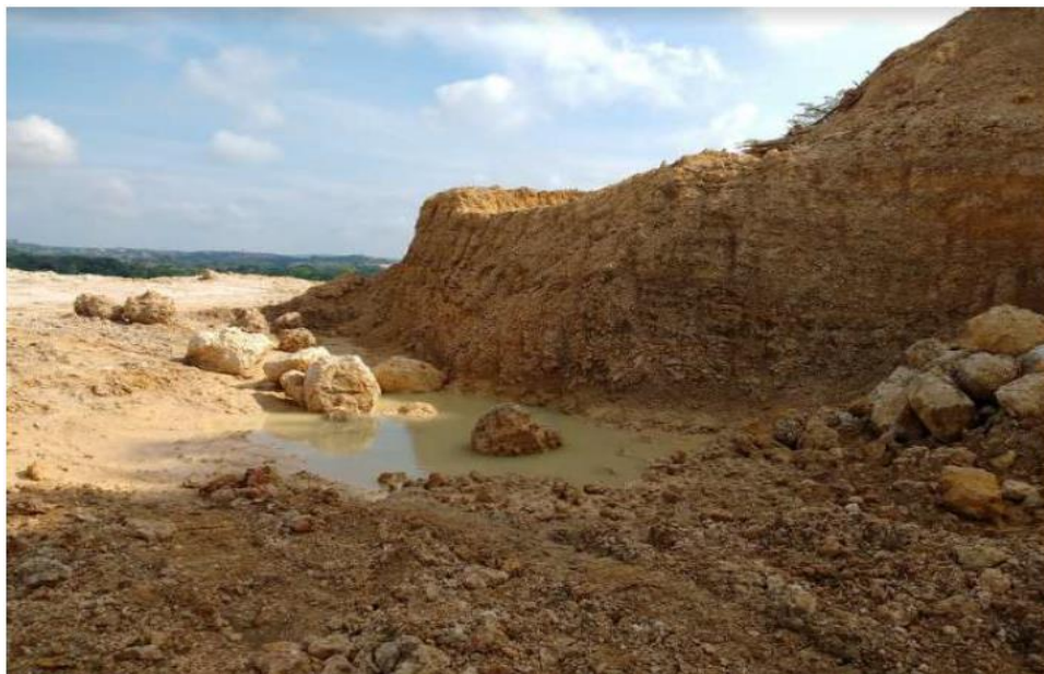
Figura 49 “Acumulación de agua en la parte superior del talud”
