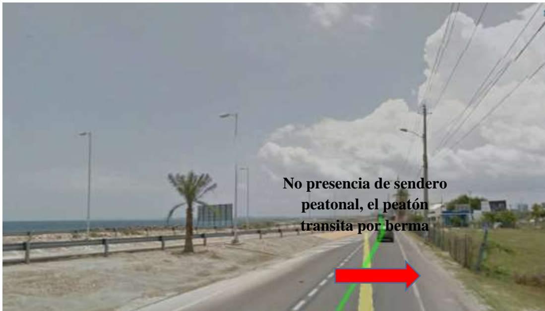
Figura 54 Evidencia de no presencia de senderos peatonales en sector 1
