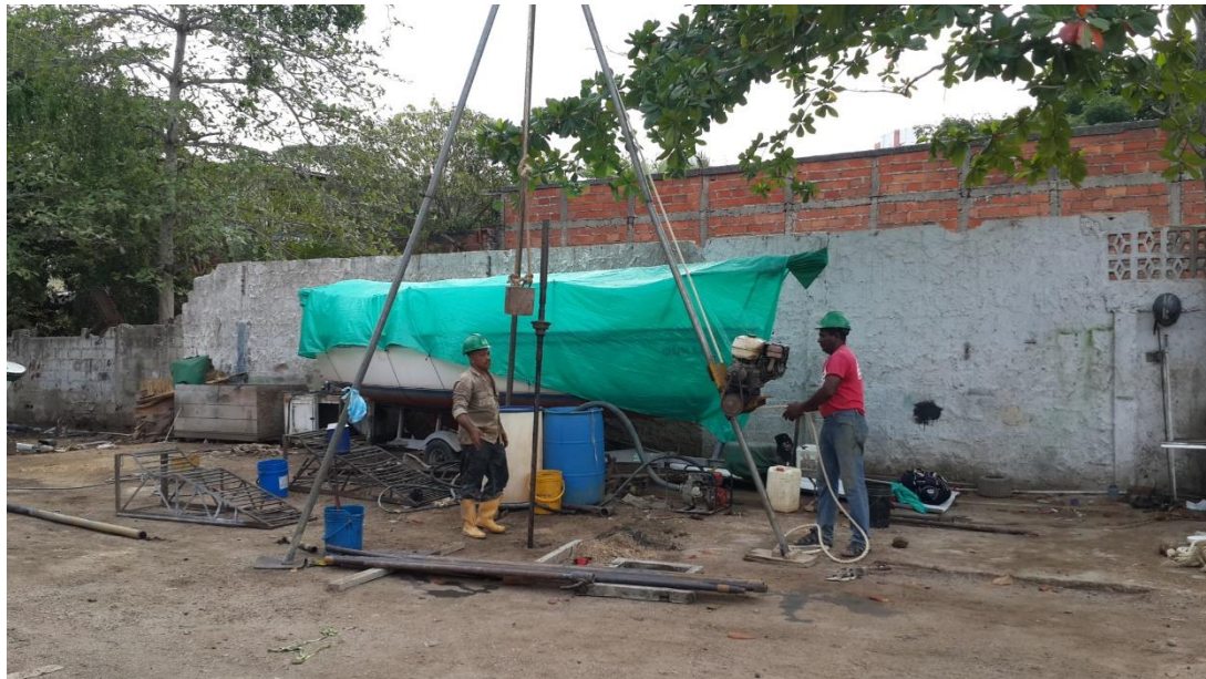
Figura A. 3. Registro fotográfico correspondiente al sondeo #3. Fuente: Guilliam Barboza Ing. Civil – MSc Geotecnia, 2016.
