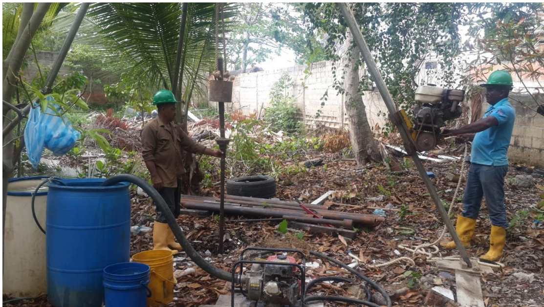
Figura A. 4. Registro fotográfico correspondiente al sondeo #4. Fuente: Guilliam Barboza Ing. Civil – MSc Geotecnia, 2016.
