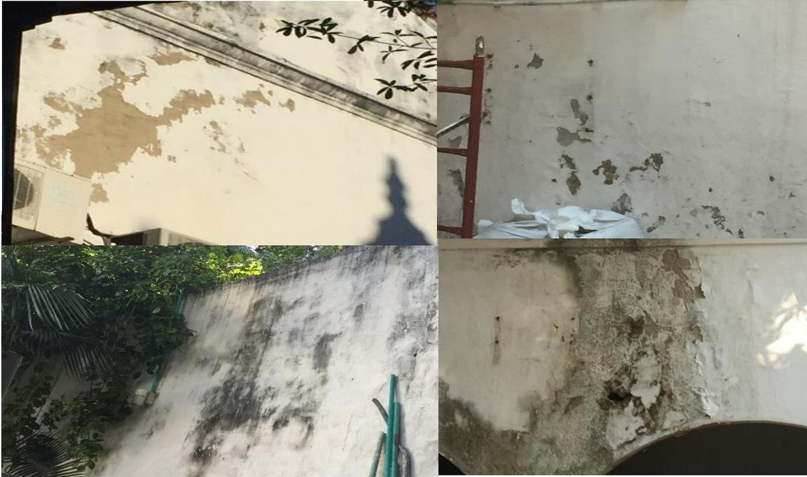
**Ilustración 5.** Se encontraron patologías en la estructura con respecto a la humedad en el patio de las oficinas de la sede del IGAC, ocasionando desprendimiento de pintura y recubrimiento de la estructura y manchas en las paredes afectadas
