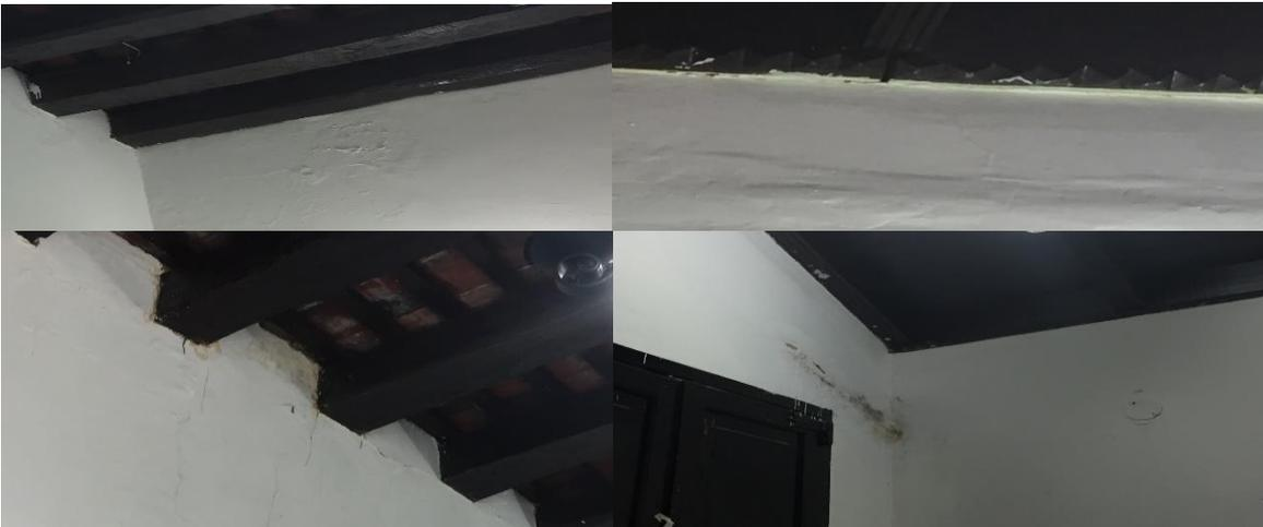
**Ilustración 2.** Se encontraron patologías en la estructura con respecto a la humedad cercana a la cubierta en el interior de las oficinas de la sede del IGAC, ocasionando desprendimiento y manchas.
