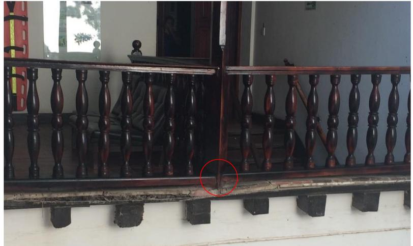
El uso de columnas de madera intermedia en los balcones, refleja la presencia de asentamiento en la placa de entrepiso.
