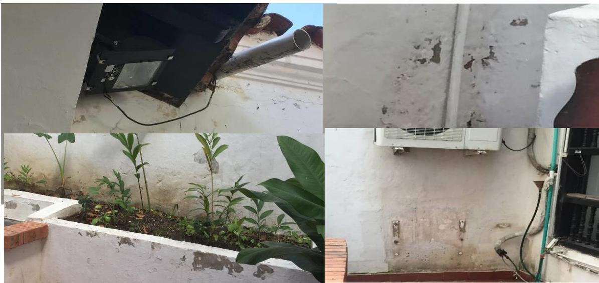
**Ilustración 4.** Se encontraron patologías en la estructura con respecto a la humedad en el patio interior de las oficinas de la sede del IGAC, ocasionando desprendimiento de pintura y recubrimiento de la estructura y manchas en las paredes afectadas.
