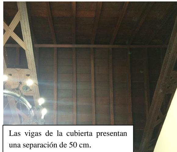
Las vigas de la cubierta presentan una separación de 50 cm.
