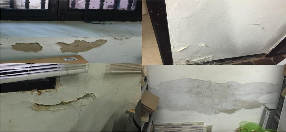
**Ilustración 3.** Se encontraron patologías en la estructura con respecto a la humedad en paredes en el interior de las oficinas de la sede del IGAC, ocasionando desprendimiento de pintura y recubrimiento de la estructura.
