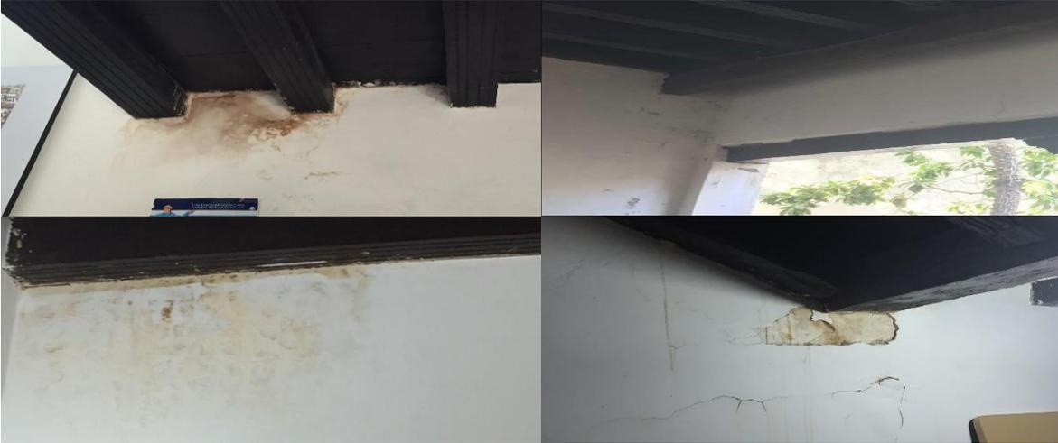
**Ilustración 1.** Se encontraron patologías en la estructura con respecto a la humedad cercana a las vigas de entrepiso en el interior de las oficinas de la sede del IGAC, ocasionando desprendimiento y manchas en paredes cercanas.
