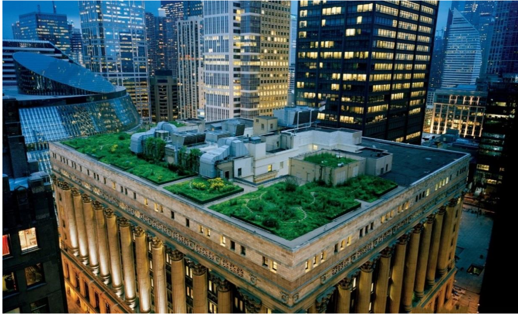
Figura 9. Edificio de la Alcaldía de Chicago.
