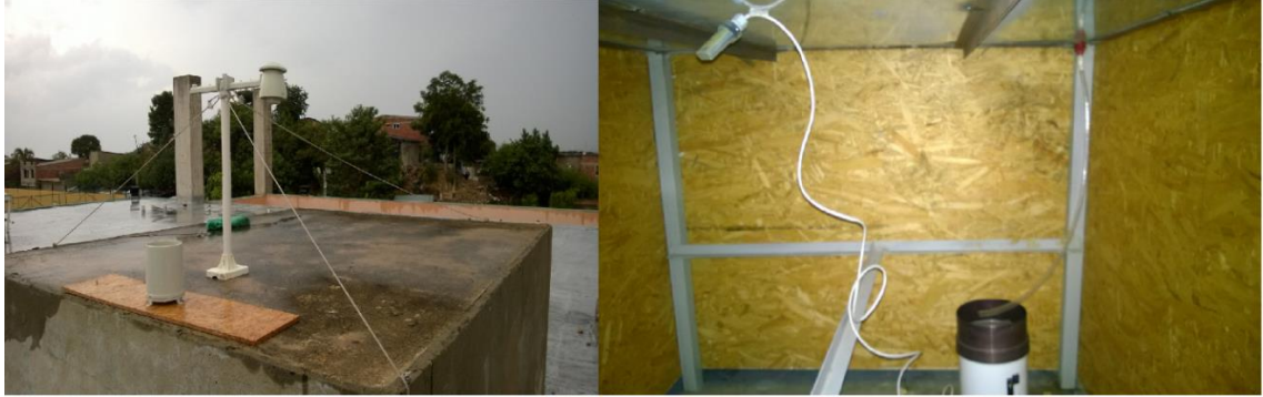
Figura 14. Esquema general de equipos de los sistemas de techo verde y ambiente. A la izquierda los equipos de medición en el primer punto y a la derecha en el segundo punto.
