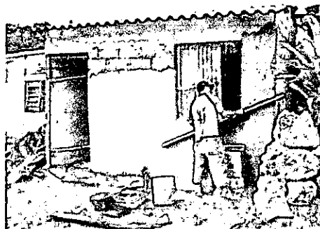
Imagen 6: Trabajo de pañete en vivienda beneficiaria.
