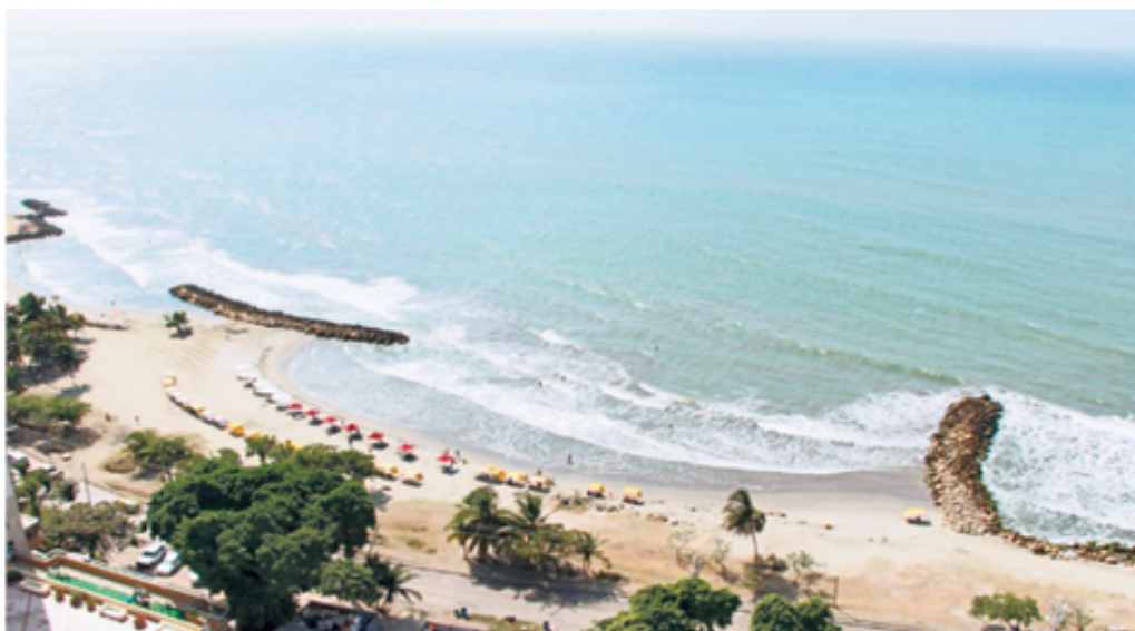
■ Las espiones y los rompeolas mantienen la estabilidad en los mares. Las primeras son estructuras en piedras ubicadas de manera vertical y las segundas se fijan de manera horizontal sobre las costas
