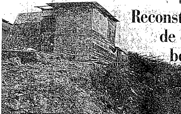
EN EL SECTOR LOMA DEL DIAMANTE, del barrio Paseo de Bolívar, fueron reconstruidas cuatro casas afectadas por la ola invernal.
