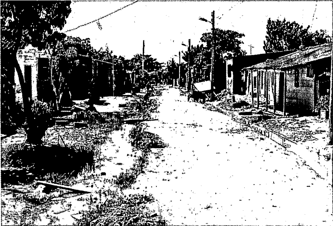
Foto No. 6 La falta de alcantarillado es uno de los problemas que afronta el sector desde hace mucho tiempo.
